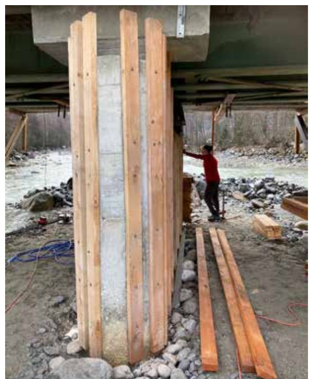
Arbeiten an der Leiersbachbrücke
