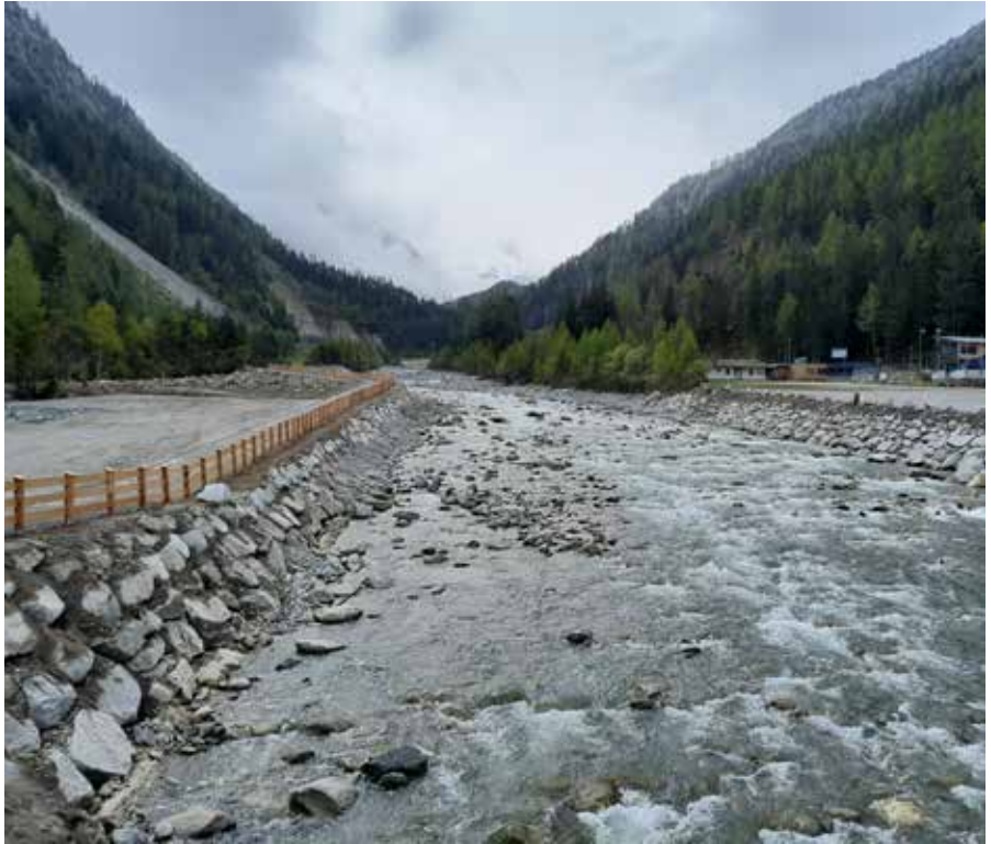
Verbau bei der Köflerstraße
