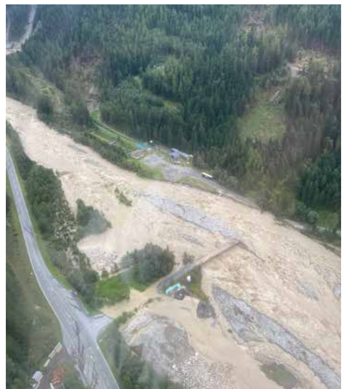
Überschwemmung der Köfler Brücke
