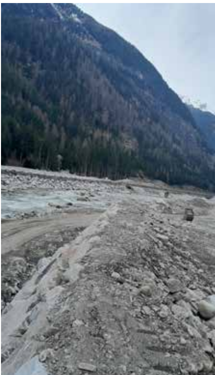
Uferverbauungen bei der Köfler Brücke
