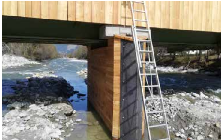
Arbeiten an der Leiersbachbrücke
