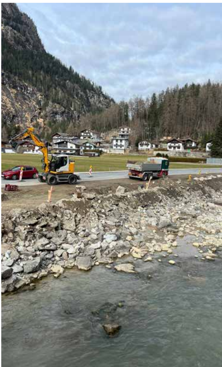
Arbeiten in Tumpen
