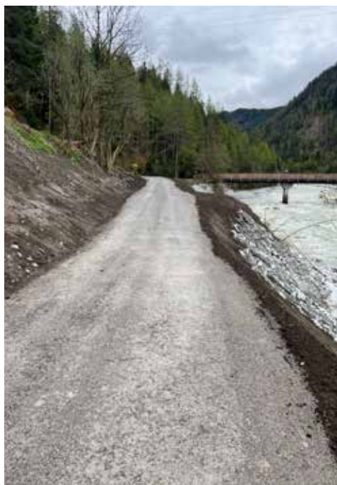
Wiederhergestellter Weg vom Fußballplatz bis zur Fundusbrücke
