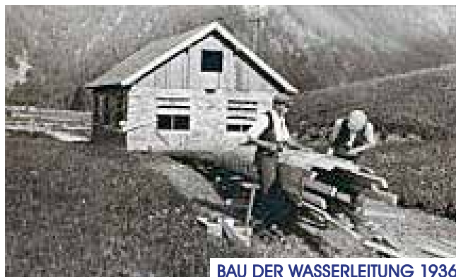
BAU DER WASSERLEITUNG 1936
