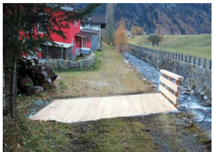
Die bestehende Brücke samt Geländer musste aus Sicherheitsgründen komplett erneuert werden.
