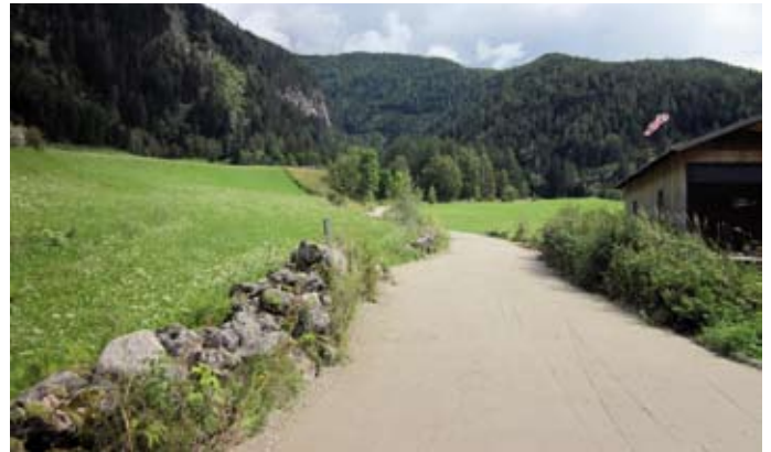
Beim Gemeindegeweg Richtung Blankenputt wurden die Schotterdecke und die Auskehrinnen erneuert.
