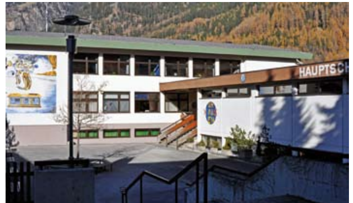
Die Schule aus den 1970ern bedarf dringend der bevorstehenden Generalsanierung.
