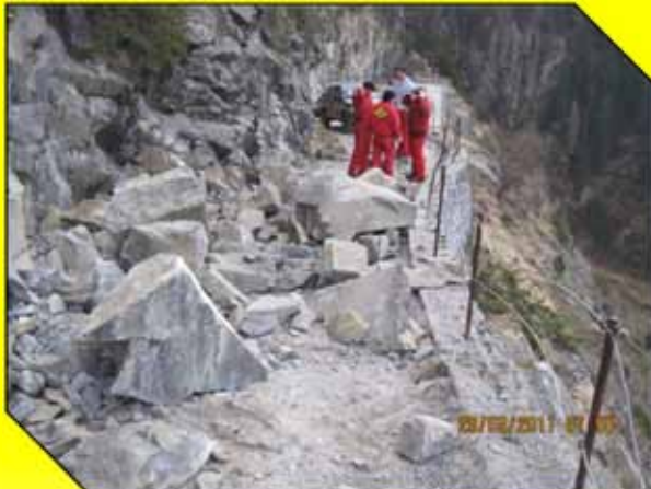
Felsberäumung Gemeindefstraße Farst
