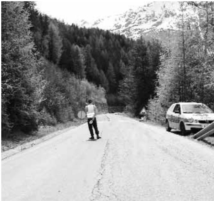
Landstraße nach Niederthai.
