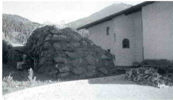
Schutzdamm beim Haus Isak im Ortsteil Sand.
